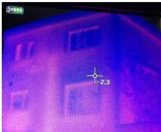
Abbildung 43: Freistehendes EFH - Heizungsstränge, Heizkörpernische, Traufe und Fassade, eigene Aufnahme
