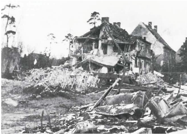
Abbildung 11: Kiefernweg, Ecke Eichkatzweg, ca. 1943 17
